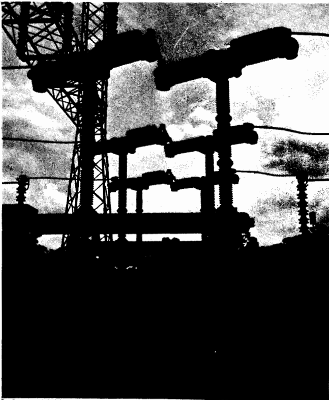
Disjuntor de 362 kV a Ar Comprimido
