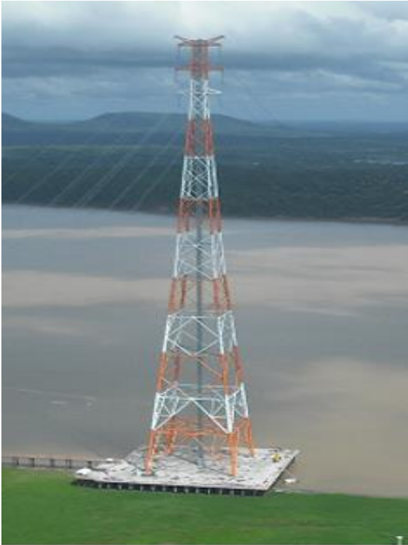
Torre no sistema Tucuruí-Manaus- Macapá 500 kV/300 m Aprox. Torre Eiffel
