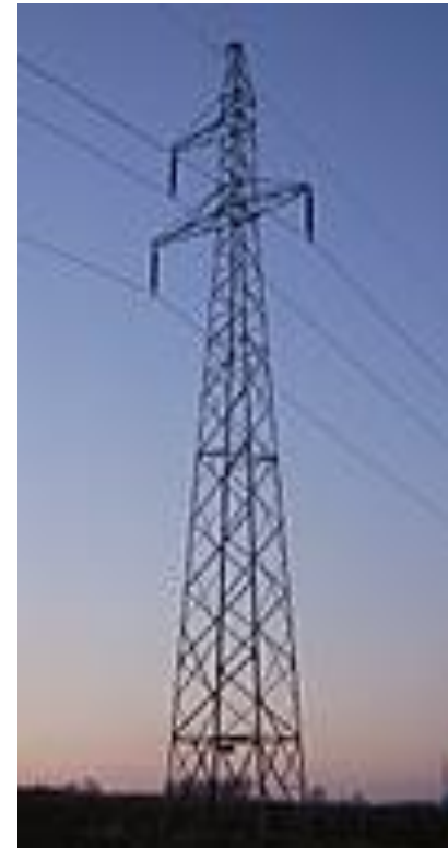
Autoportante circuito simples 138 kV/25 m
