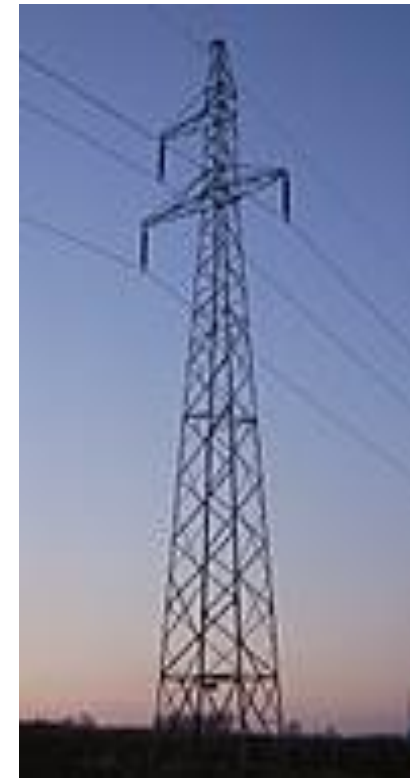
Autoportante circuito simples 138 kV/25 m
