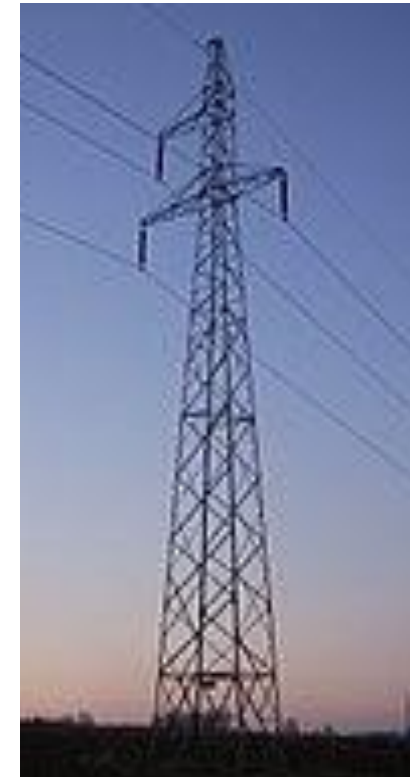
Autoportante circuito simples 138 kV/25 m
