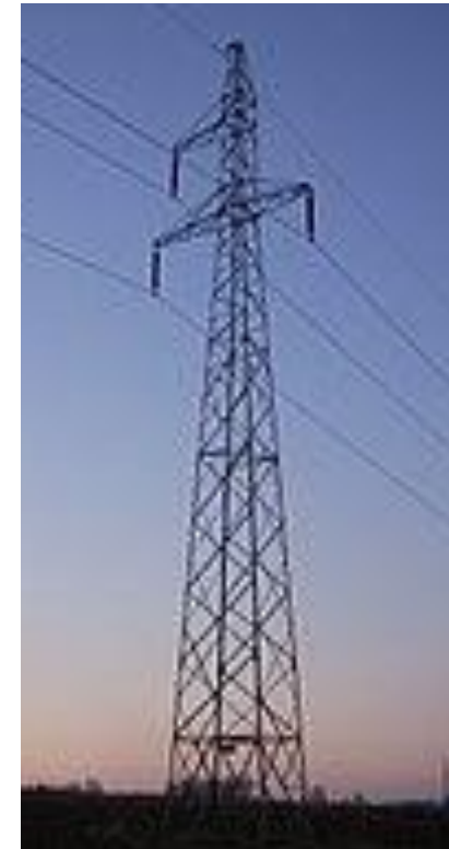
Autoportante circuito simples 138 kV/25 m
