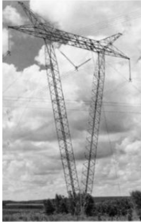
Estaiada 440 kV/46 m
