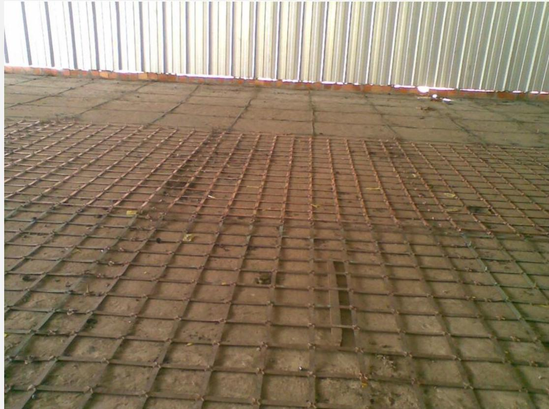
Figura 1: Malha de aterramento a ser instalada (Molchansky, 2020)
