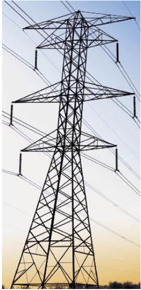
Autoportante circuito duplo 400 kV/45 m
