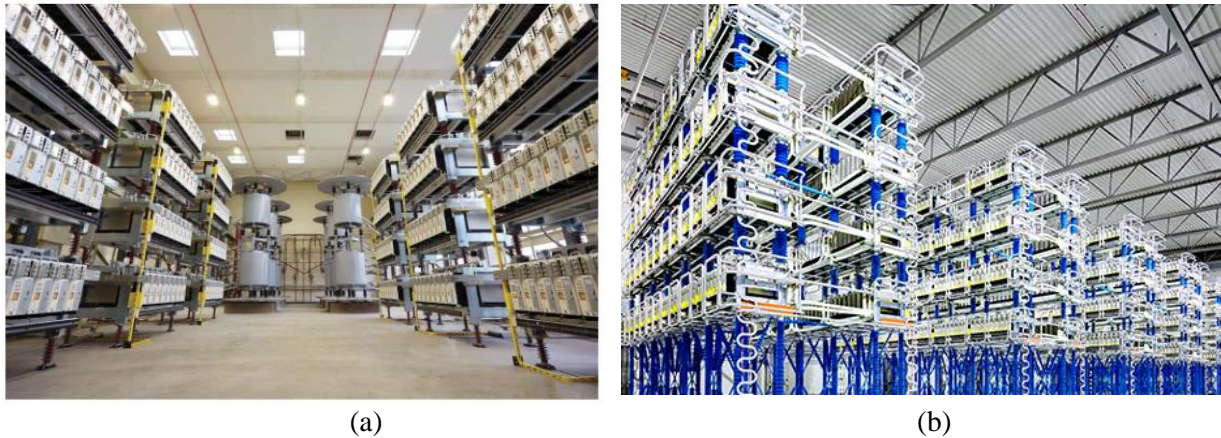
Figura 6.100. Sistema VSC-HVDC MaxSine HVDC. (a) Projeto piloto. (b) Projetos comerciais.
