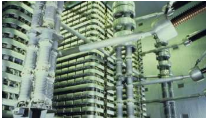
Conjunto de tiristores formando uma válvula no sistema retificador de Itaipu
