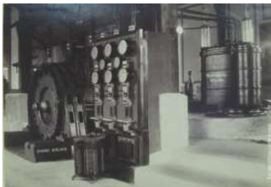
Dolivo-Dobrovolsky e as instalações pioneiras da hidrelétrica em Lauffen, Alemanha, no rio Neckar (1891). O gerador de à esquerda e o transformador à direita.
